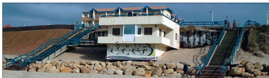
Poste de secours et escaliers actuellement.
